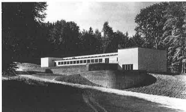
ABB. 11 | Der Neubau für die Pathologie wurde 1933 im Bauhausstil errichtet. Der pathologisch-bakteriologischen Abteilung stand von 1919 bis 1947 mit Helene Kloss die erste Chefarztin an einem Schweizer Spital vor.
